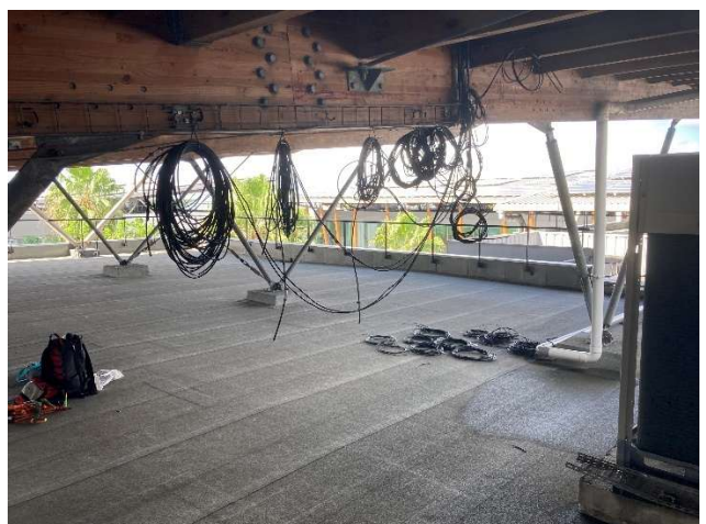
Défauts sur câbles et mise en attente après débranchement
