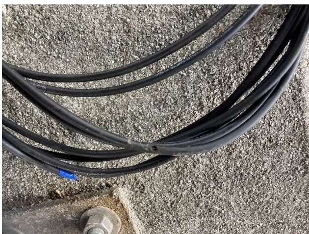
Défauts sur câbles et mise en attente après débranchement
